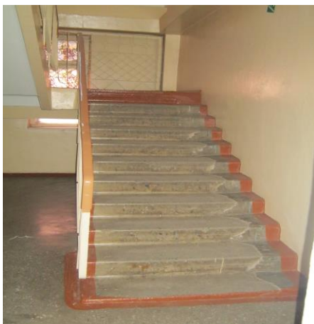
Фото 10. Лестница внутри здания (6 шт.).
