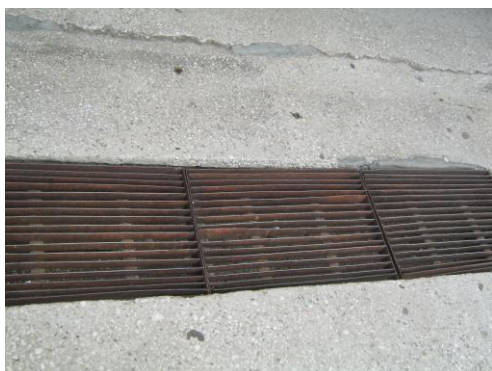
Фото 5. Входная площадка перед дверью.
